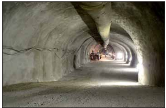
Obr. 4 Zrealizovaný núdzový záliv v južnej tunelovej rúre v primárnom ostení
