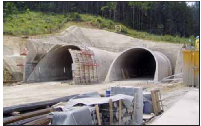
Obr. 7 Zrealizované hĺbené časti tunela na východnom portáli Fig. 7 Completed cut-and-cover sections of the tunnel at the eastern portal
