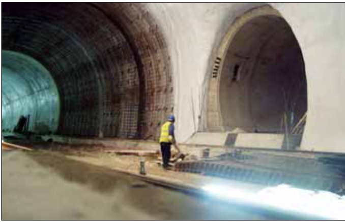
Obr. 6 Realizácia sekundárneho ostenia tunela v mieste priečného prepojenia
