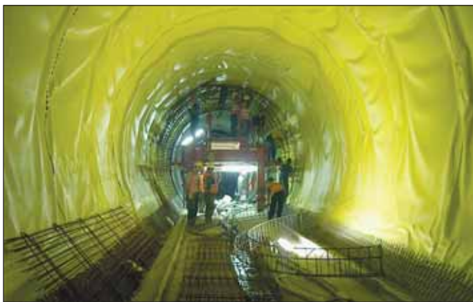
Obr. 5 Realizácia plošnej hydroizolácie a výstuže v únikovej štólňi Fig. 5 Installation of the waterproofing system and reinforcement in the escape gallery
