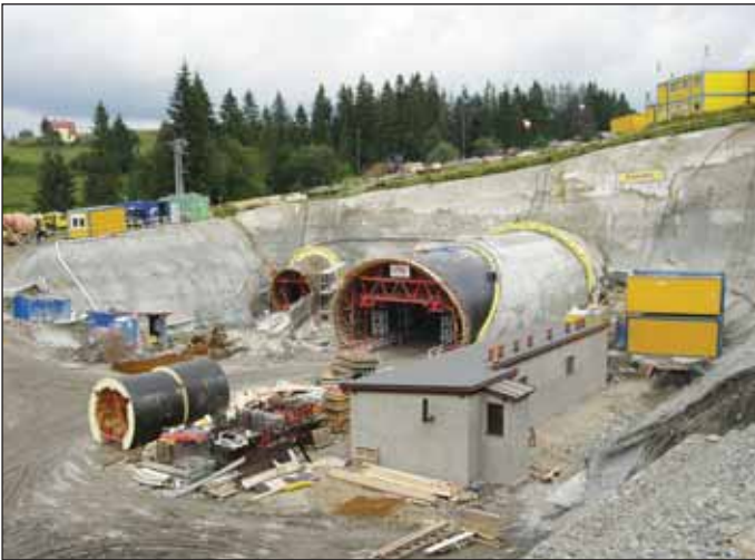
Obr. 3 Južný portál – realizácia hlbeného tunela Fig. 3 Southern portal – cut-and-cover tunnel construction
