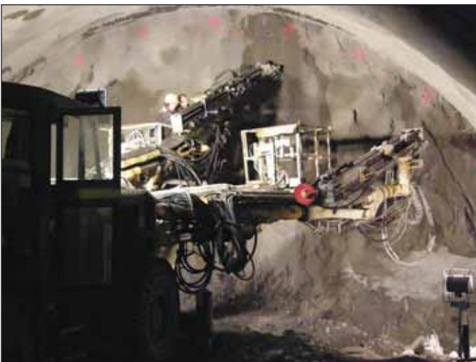
Obr. 4 Realizácia primárneho ostenia hlavného tunela Fig. 4 Installation of the primary support of the main tunnel excavation
